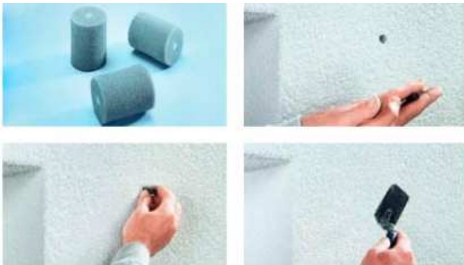
Figura 47. Detalle de una tapa de anclaje de andamio y su correcta instalación.
