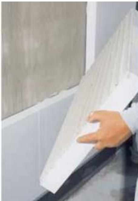
Figura 5. Detalle del pegado de una plancha de aislamiento en toda la superficie
