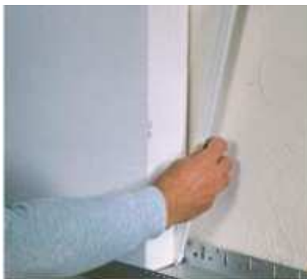
Figura 14. Fotografía de la instalación de los listones de unión.
