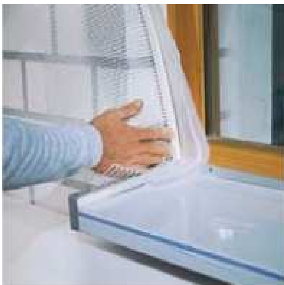
Figura 28. Instalación del aislamiento y detalle de solape de la malla de armadura en una ventana.
