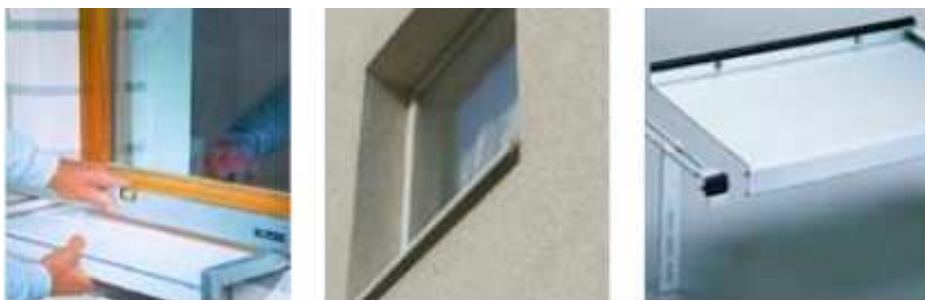
Figura 48. Detalle de un vierteaguas.
